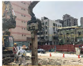
安全支撐工程 中間樁共構樁施作
