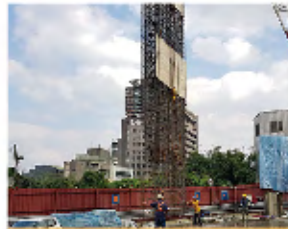
連續壁工法 吊放鋼筋籠
