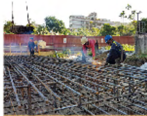
連續壁工法 鋼筋籠焊接
