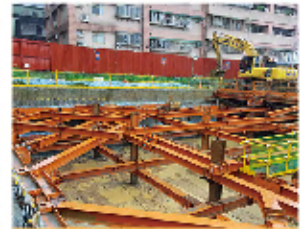
安全支撐工程 安全支撐材施作
