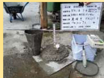
混凝土氯離子試驗
