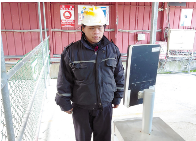
· 工地裝設人臉辨識系統與設備。
