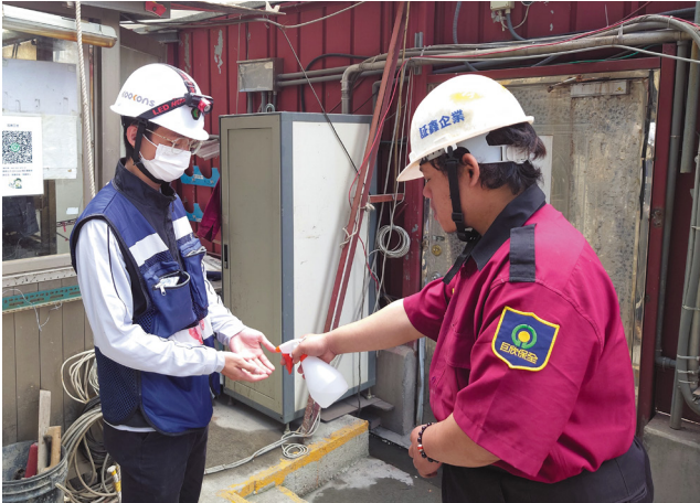
· 宏盛建設落實工地防疫消毒。
